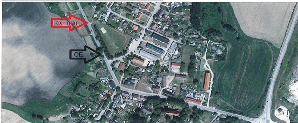
Ortsdurchfahrt Glasin im Zuge der Kreisstraße 39
