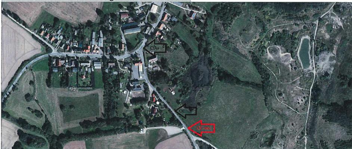
Ortsdurchfahrt Babst im Zuge der Kreisstraße 39
